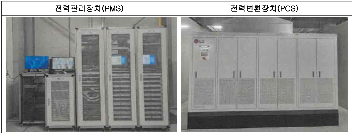
(그림 5-2) 에너지 저장 장치 정보 및 구성요소
